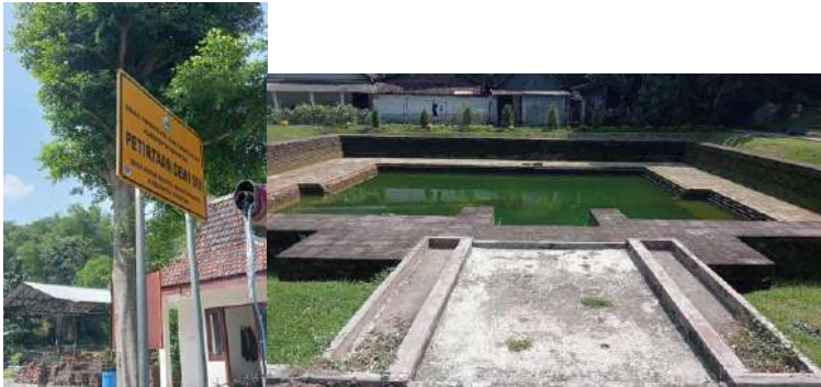
Gambar 1: Petirtaan Dewi Sri dengan airnya yang masih penuh (Sumber: Dokumentasi pribadi)
