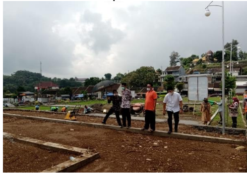
Foto: Peninjauan pembangunan sampai pada tahap selesainya struktur bawah
