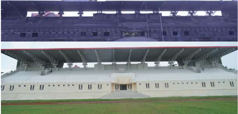
Foto: Stadion Sadurunge Lan Sak Wise Dibangun
